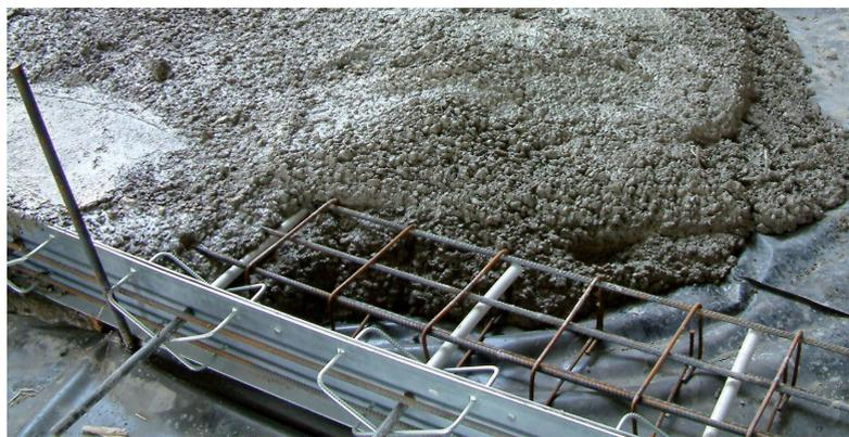
■ Figura 5. Giunto di costruzione preformato.
