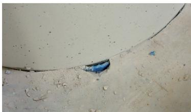
■ Figura 3. Giunto di isolamento mal riuscito. La colonna è isolata dalla lastra, ma il nastro di resina spugnosa è disposto al di sotto del piano del pavimento; inoltre ha una massa volumica esigua e una elevata compressibilità che non assicura di impedire la penetrazione di elementi estranei. Il buon funzionamento del dispositivo è incerto.
